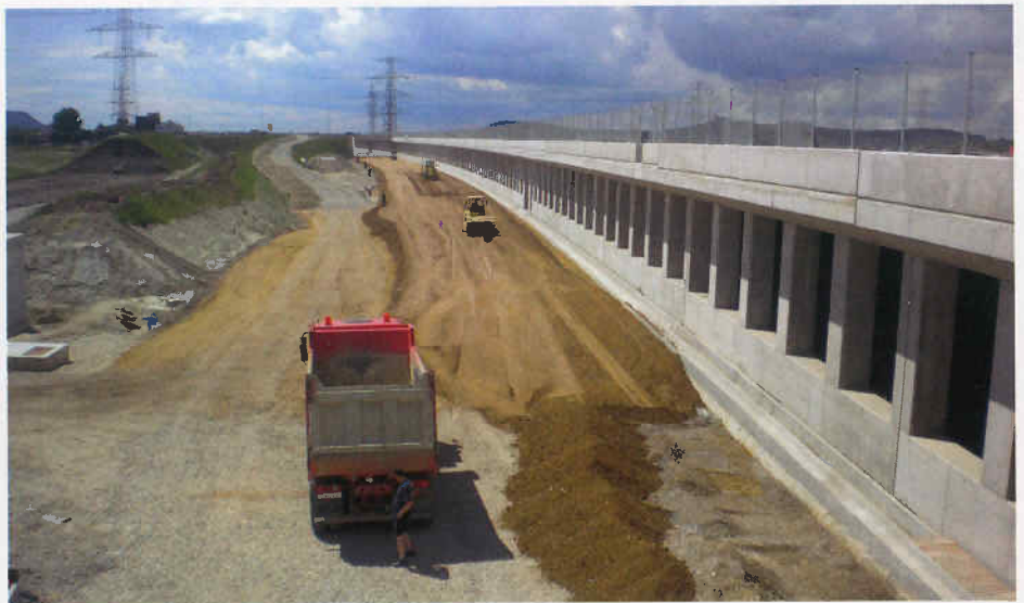
Das größte Objekt des Projektes war der Straßentunnel Stetten, der in offener Bauweise errichtet wurde
