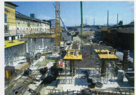
Fig. 3. Work on the track structures Bild 3. Arbeiten an den Gleisstragwerken
