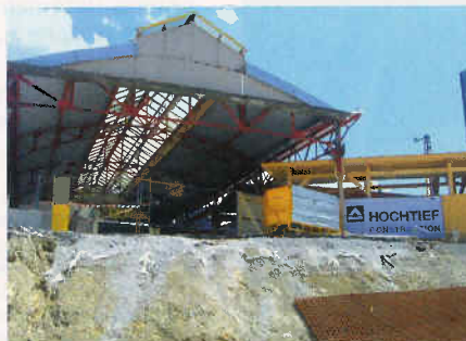
Fig. 2. Listed platform roof (being restored) Bild 2. Denkmalgeschützte Überdachung (wird restauriert)
