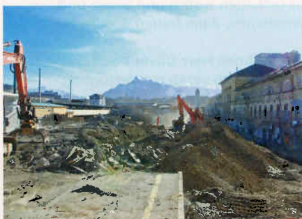
Fig. 1. Excavation for the central passage Bild 1. Baugrubenaushub für die zentrale Passage
