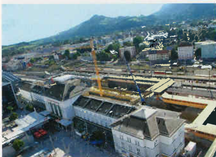
Fig. 4. View of the construction site Bild 4. Baustellenüberblick
