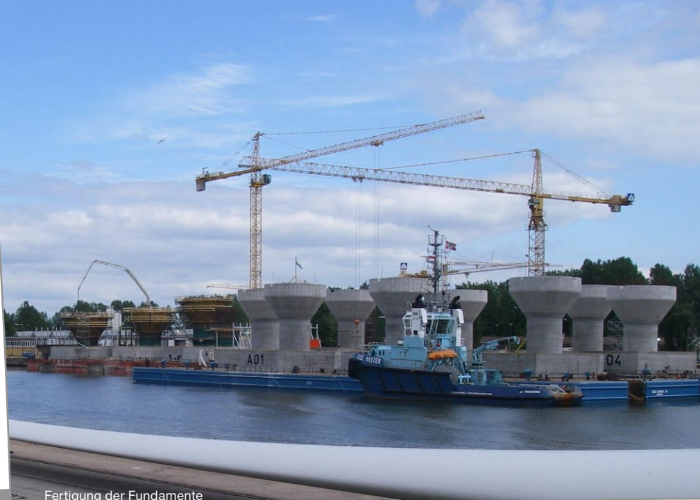
Fertigung der Fundamente
